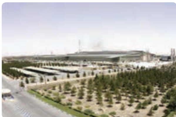
شکل ۹-۶- شرکت فولاد آلیازی اشکذر
